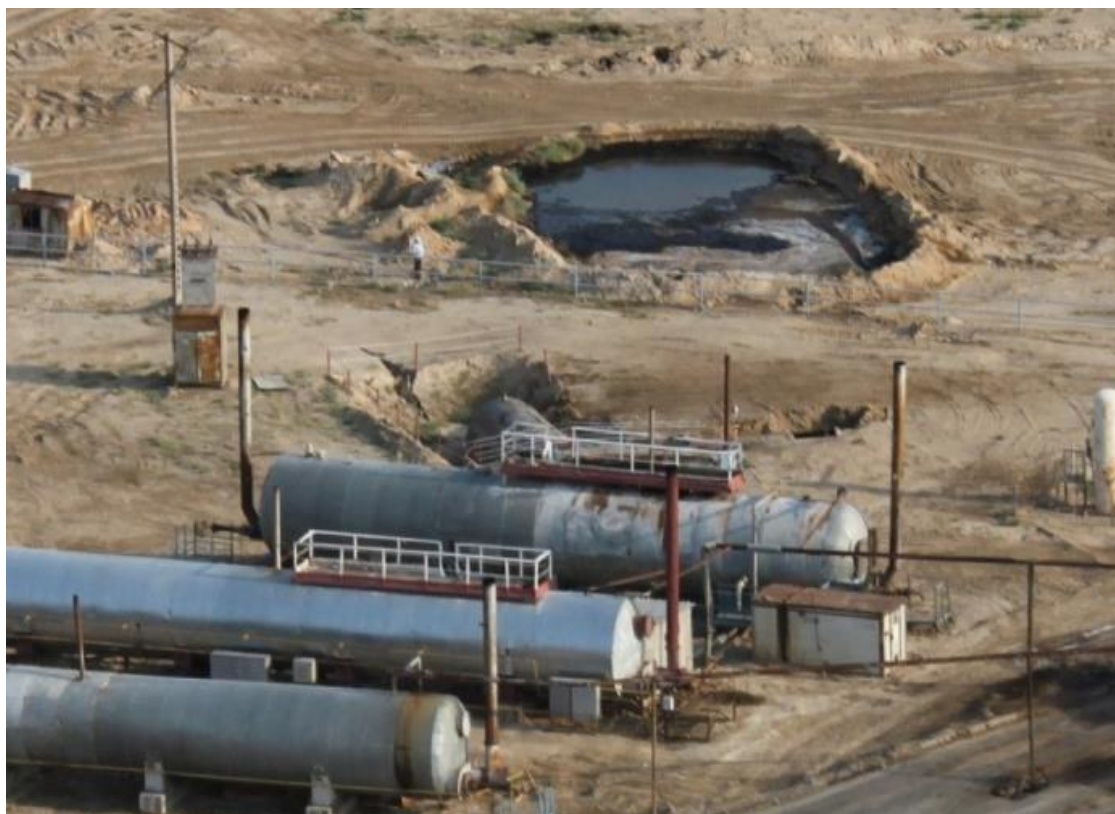
Рисунок 2. Нефтяные отходы близ производственных сооружений в Мангистауской области [5].
